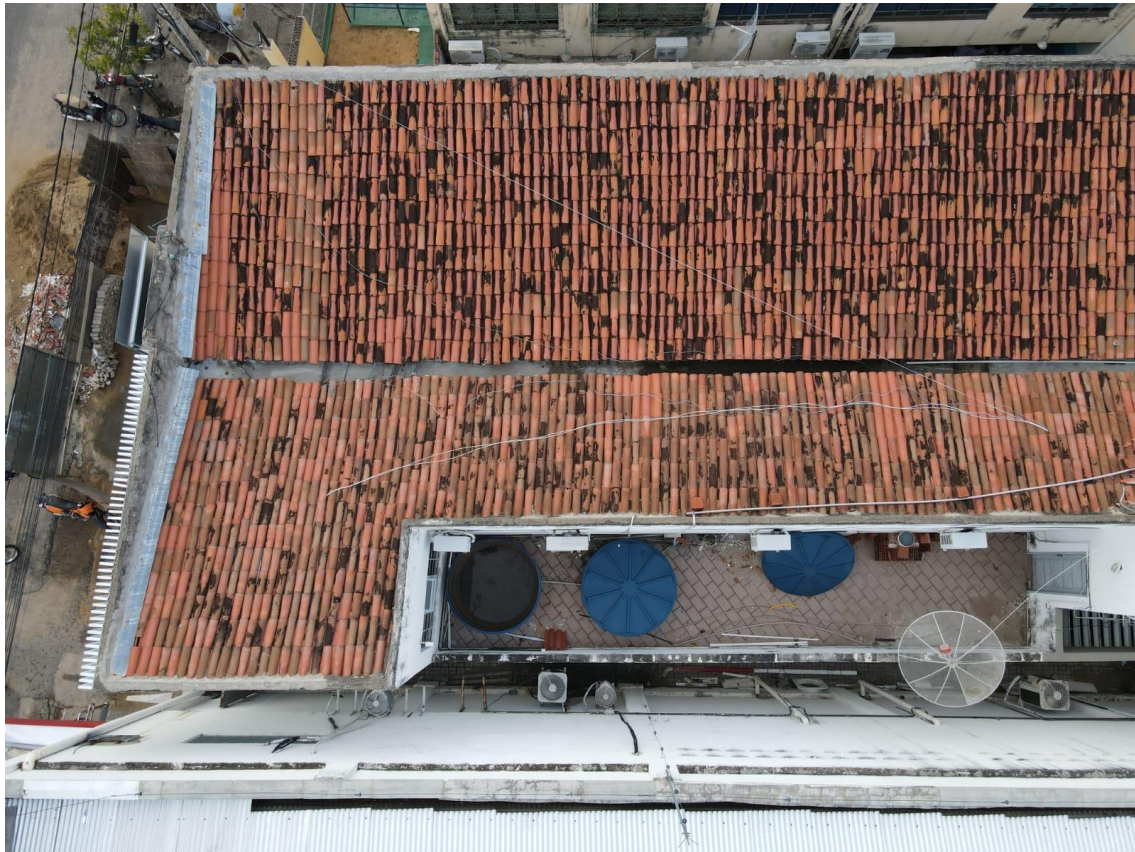
Figura 09-Vista aérea varanda do pavimento superior
