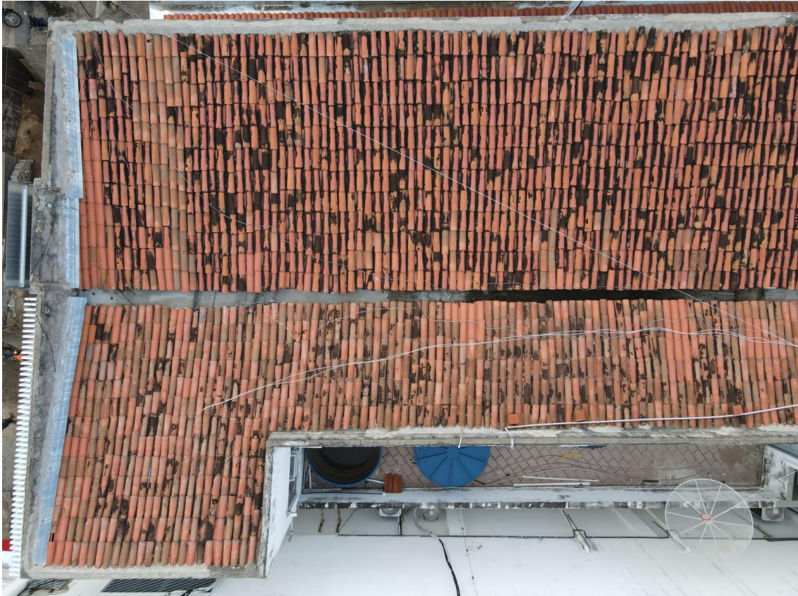
Figura 08-Vista aérea do telhado início da edificação
