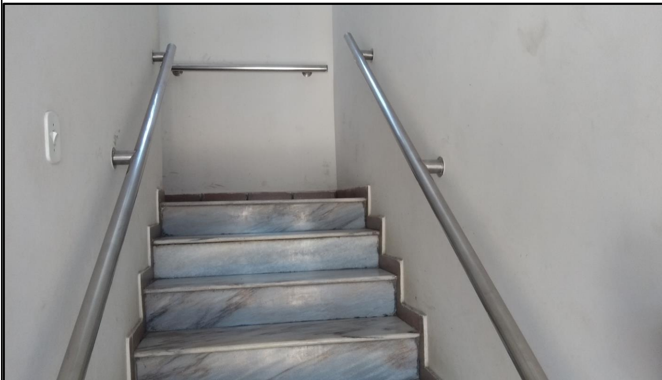
Foto 3 - Corrimão da escada existente
